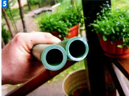
5 Неармированная полипропиленовая труба для холодной воды и армированная полипропиленовая труба — для горячей.
