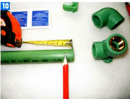
10 На трубе делали отметку, на какую глубину её нужно вставить в фитинг при сварке.
