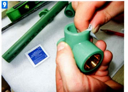
9 Перед сваркой поверхности труб и фитингов обезжировали.
