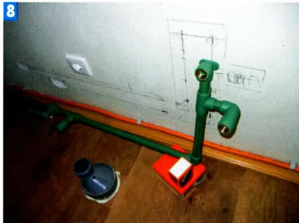
8 Для предупреждения ошибок рисовали схему сборки узла водопровода мелом на стене.
