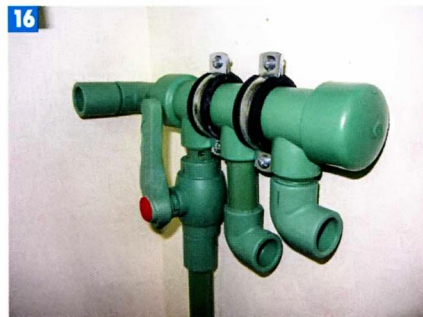
16 Коллектор линии горячей воды собрали несколько по другой схеме.
