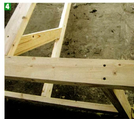
4 Каркас подстоля практически готов. Осталось только установить второй раскос, обеспечивающий нужную жёсткость конструкции.
