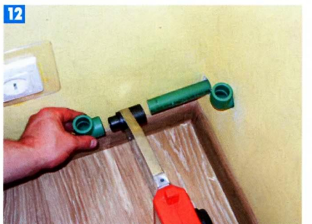
12 В некоторых случаях прогревать трубу и фитинг приходилось непосредственно в зоне монтажа трубопровода.
