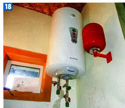
18 Накопительный электрический водонагреватель и расширительный бак установили по месту.
