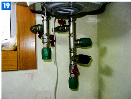
19 Вентили и клапаны системы безопасности и слива воды накопительного водонагревателя собрали по тщательно продуманной схеме.
