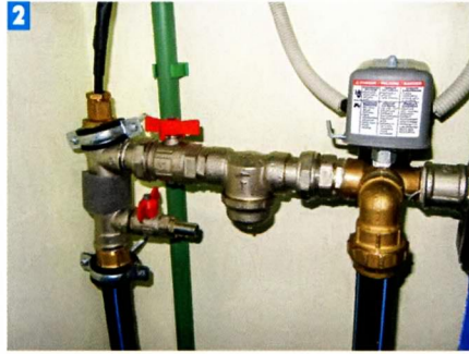
2 Доступ к кабелю подогрева трубопровода, реле давления и фильтру грубой очистки организован в одном месте.
