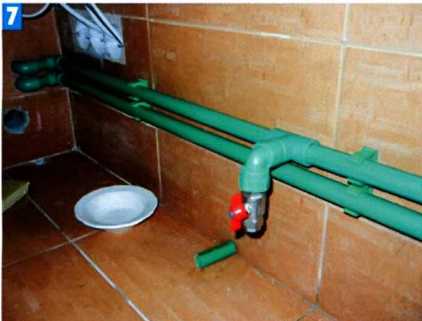
7 Вентиль для слива воды установили в нижней точке трубопровода.
