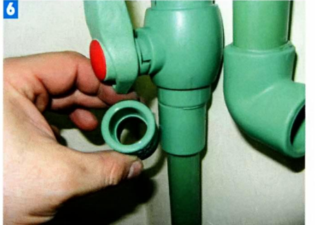
6 С помощью соединительной муфты можно сращивать длинные участки трубопровода либо исправлять ошибки монтажа.
